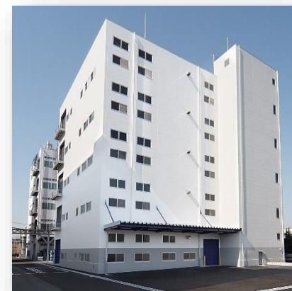
泉工場製造棟（大阪府泉大津市）
