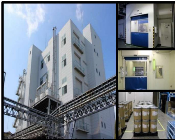
泉工場製造棟 (大阪府泉大津市)
