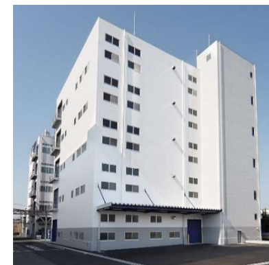
泉工場製造棟 (大阪府泉大津市)
