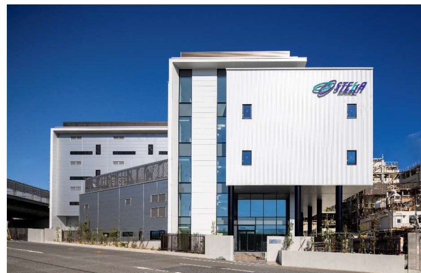
次世代材料研究棟（三宝工場敷地内）
