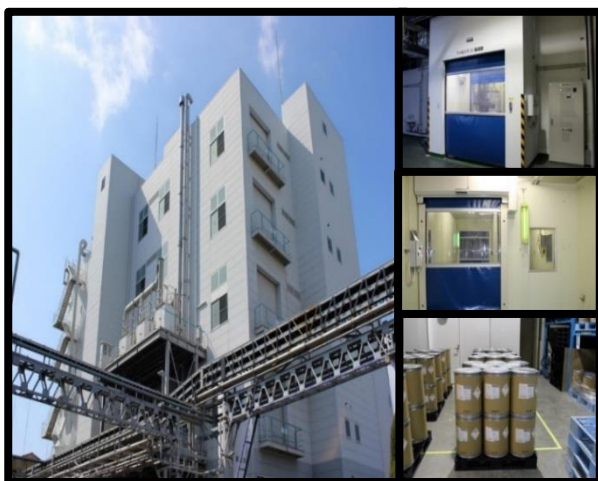
泉工場製造棟 (大阪府泉大津市)
