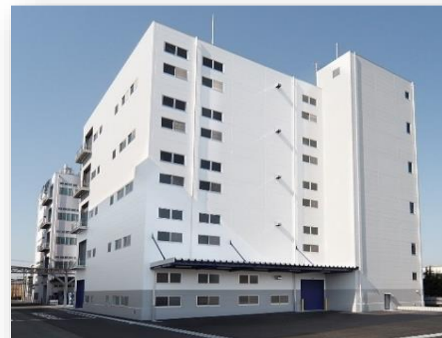
泉工場製造棟（大阪府泉大津市）
