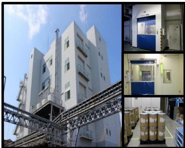
泉工場製造棟（大阪府泉大津市）
