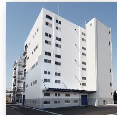
泉工場製造棟 (大阪府泉大津市)
