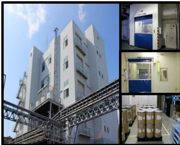
泉工場製造棟（大阪府泉大津市）
