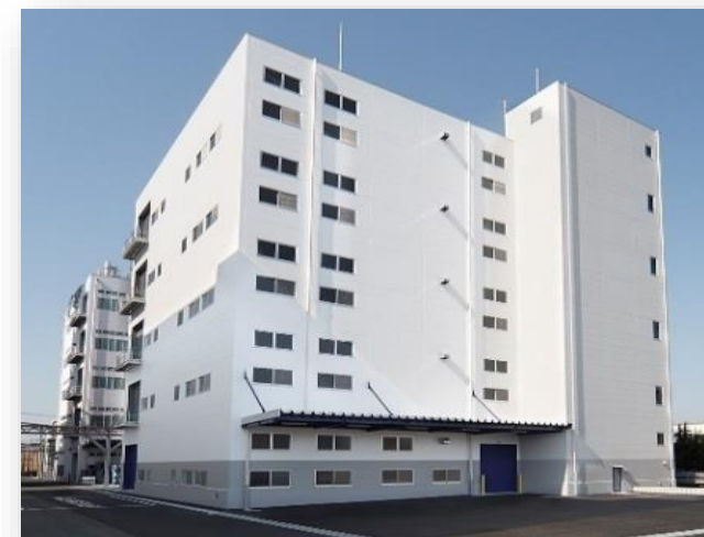
泉工場製造棟（大阪府泉大津市）
