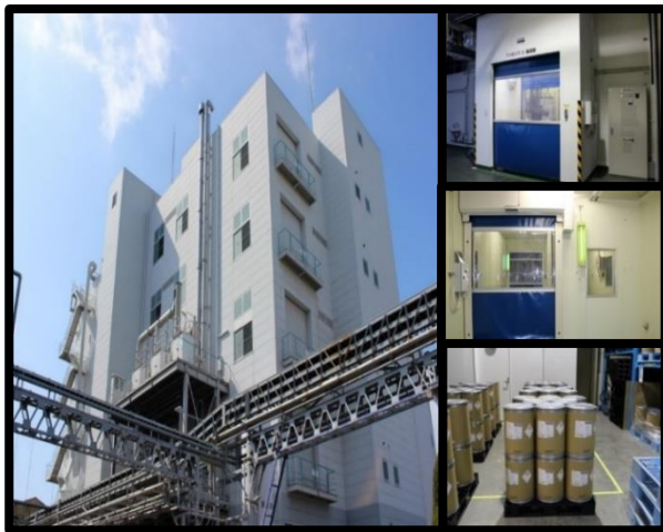
泉工場製造棟（大阪府泉大津市）
