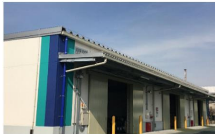
本社新危険物倉庫 2018年12月完成
