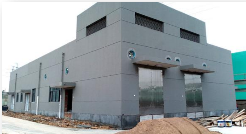
ユーティリティー棟
