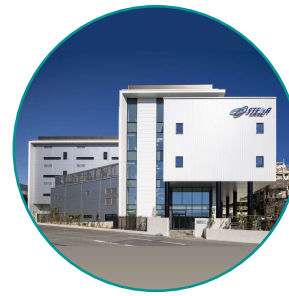
次世代材料研究棟
