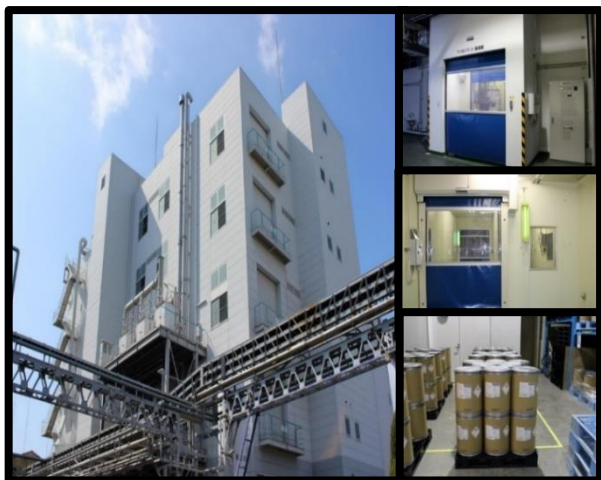
泉工場製造棟 （大阪府泉大津市）
