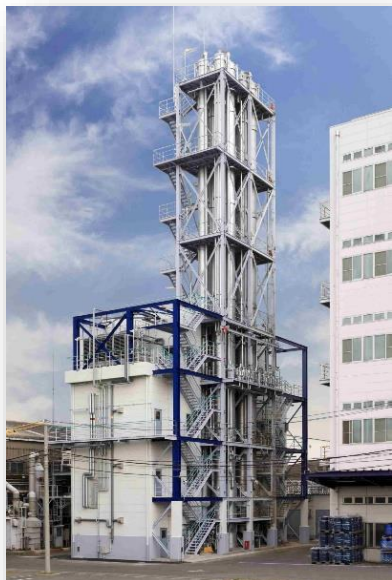
濃縮プラント (大阪府泉大津市)
