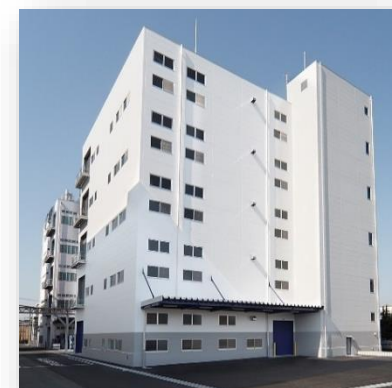
泉工場製造棟（大阪府泉大津市）
