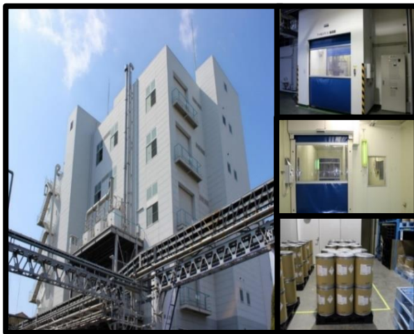
泉工場製造棟 (大阪府泉大津市)
