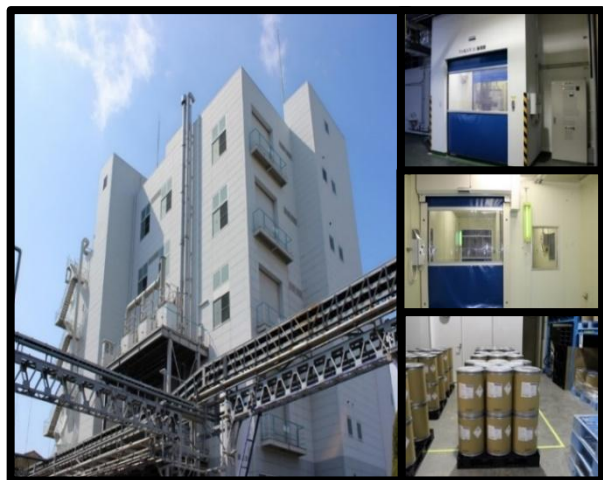
泉工場製造棟（大阪府泉大津市）
