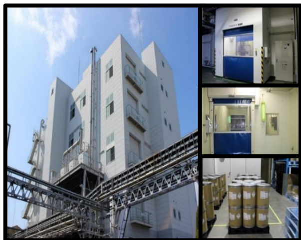
泉工場製造棟 （大阪府泉大津市）
