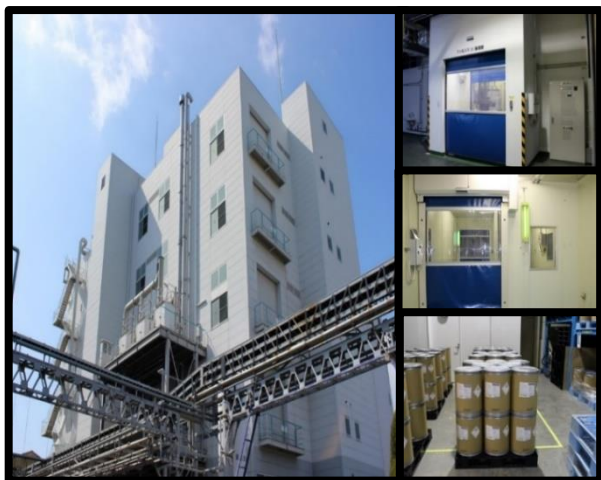
泉工場製造棟 （大阪府泉大津市）
