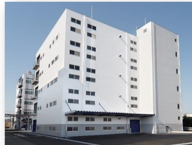
泉工場製造棟（大阪府泉大津市）
