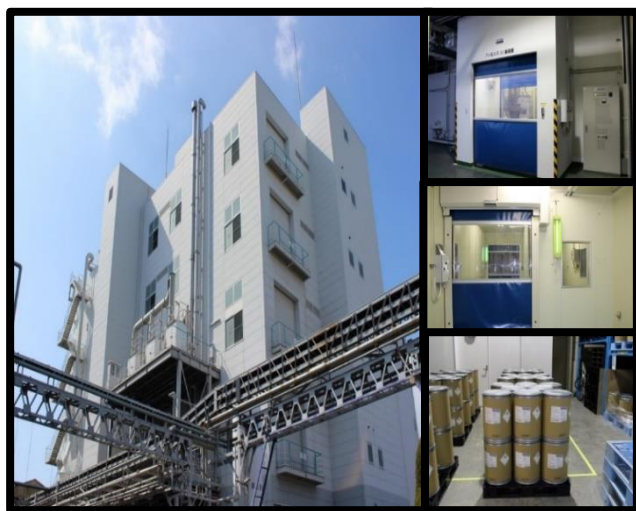
泉工場製造棟 (大阪府泉大津市)
