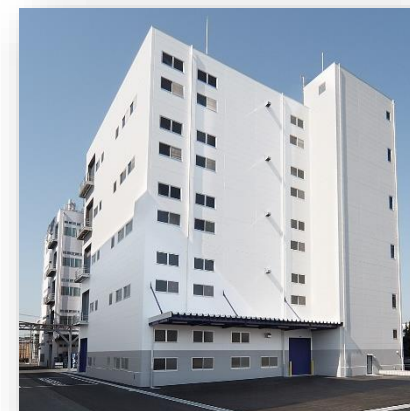
泉工場製造棟 (大阪府泉大津市)
