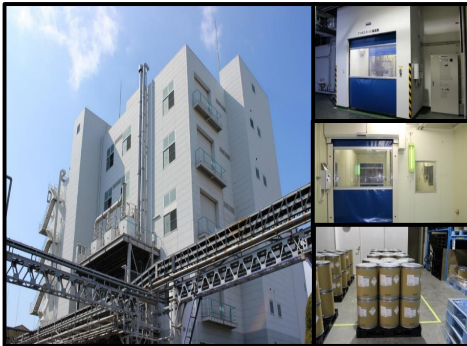
泉工場内 (大阪府泉大津市)
