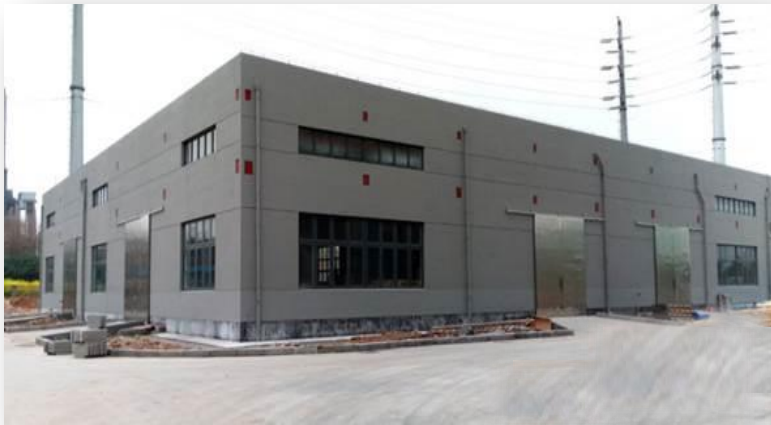
製品および原料倉庫
