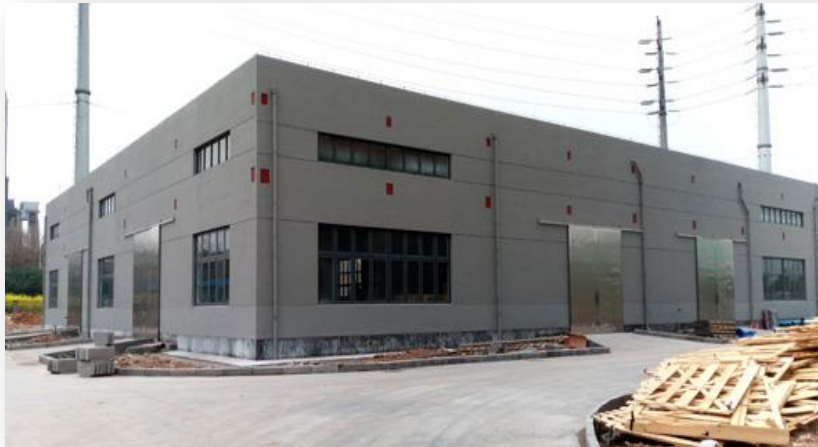
製品および原料倉庫
