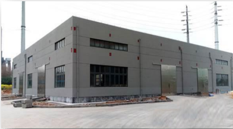
製品および原料倉庫
